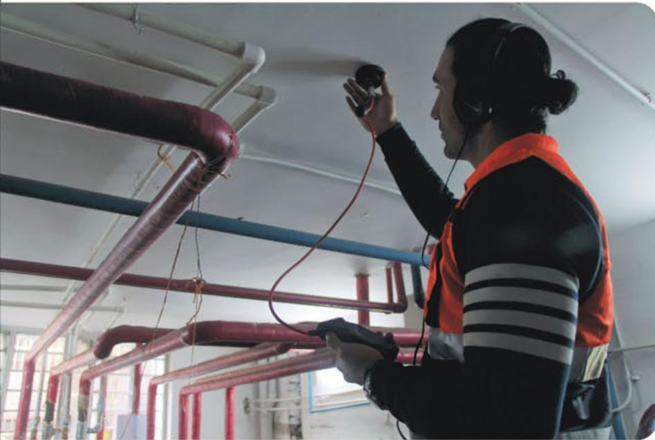
Notch نشت یاب هوشمند آکوستیک آب مدل پریجا مینی (تجهیز به قابلیت قضاوت اتوماتیک وجود نشت آب) نشت یاب آکوستیک آب پریجا مینی مدل PERIJA mini VPICK-UP به طور تخصصی جهت نشت یابی شبکه آب با سنسور ژئوفون یا سنسور PICK-UP طراحی شده است این دستگاه قابلیتها را وساختار طراحی دستگاه PERIJA mini VPRO داشته اما به دلیل بهره‌گیری از سنسور ژئوفون در شکل PICK-UP جهت نشت یابی خطوط مدفعون که دسترسی به شبکه آن وجود ندارد مناسب است.
