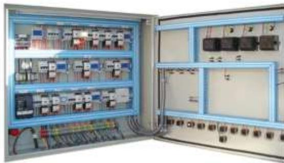
کلیه تجهیزات برقی نصب شده در بخش های مختلف سیستم تصفیه فاضلاب از قبیل پمپ ها، الکتروموتورها، بلونر های هوادهی، کلرزنی و غیره از واحدی تحت عنوان اتاق کنترل و به وسیله تابلوی برق کنترل می شوند.
